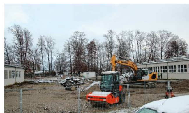
Die Bauarbeiten auf dem Areal haben jetzt begonnen. Wenn alles nach Plan läuft, soll das Projekt im Spätsommer fertig sein.
